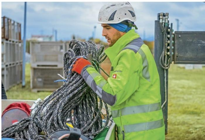
**Sicherheitscheck** Alle Arbeitsmittel werden von den Freileitungsmonteuren vor und nach dem Einsatz überprüft
